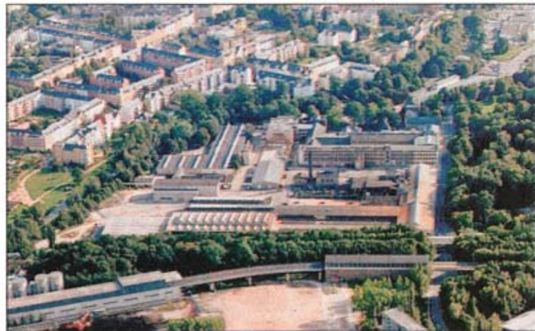
Das Firmengelände von Trompetter Guss aus der Vogelperspektive: Das Unternehmen will die Produktionskapazitäten verdoppeln, dazu 23,6 Millionen Euro investieren. –FOTO: ULF DAHL
