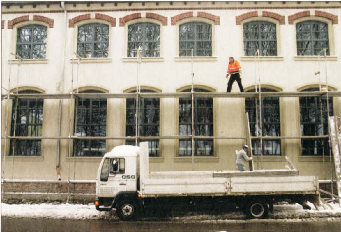
Nach umfassender Sanierung wird die große Gießereihalle an der Schönherrstraße abgerüstet. Mit der Sanierung ist ein jahrzehntelanger Schmutzleck am Fuße des Schlossbergs beseitigt.
